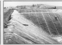
Zastosowanie mat BENTIZOL do uszczelnienia składowiska odpadów
