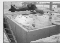
Użycie mat BENTIZOL do uszczelnienia zbiornika składowiska komunalnych.
