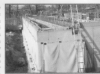
Uszczelnienie fundamentów za pomocą mat BENTIZOL
