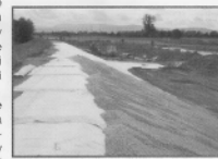
Wykorzystanie mat bentonitowo-haloizytowych przy budowie wałów przeciwpowodziowych
